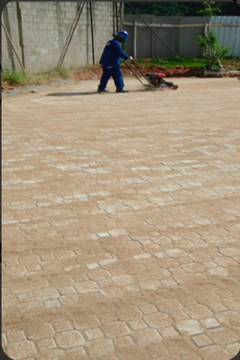
Salgar o piso é um expressão utilizada no qual se refere ao espalhamento da areia sobre toda superfície do piso. Essa areia irá penetrar entre as juntas no qual ocorrerá o processo de travamento das peças. Os pisos deverão ser compactados com placa vibratória. Após a utilização da placa é necessários o auxilio de vassouras para complementar o preenchimento entre as peças.
